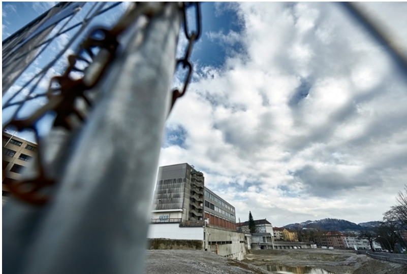
Bis hier gebaut wird, dauert es noch: Das Warmbächli-Areal. Bild: Manu Friederich
